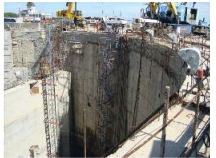
Acindar Grupo ArcelorMittal zaangażowany jest w realizację projektu modernizacji tuneli Maldonado w Buenos Aires. Podziemny system odprowadzania wody wymaga zastosowania stali o wysokiej odporności do zbrojenia betonu użytego do budowy tuneli i ogromnego szybu dostępu.
