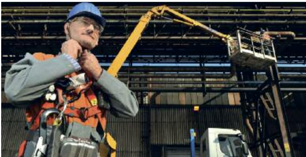
Yves Pieters, pracownik ArcelorMittal wykonuje prace na rurociągach w rejonie walcowni zimnej w Gent (Belgia). Ponad 200 000 pracowników i wykonawców ArcelorMittal zaproszonych jest do wzięcia udziału w tegorocznych obchodach Dnia Bezpieczeństwa i Zdrowia w ramach naszej Podróży do Celu: Zero Wypadków.
